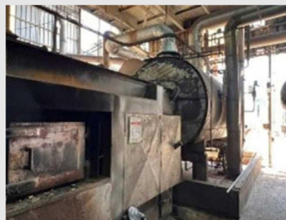
AQF01 - AQUECEDOR DE FLUÍDO TÉRMICO COMPLETO COM QUEIMADOR BIOMASSA INTEGRADO CAPACIDADE 1.600.000 KCAL/H | Item: 97 |
