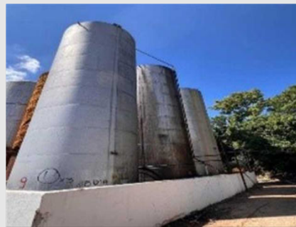
TQMP09 /TQMP10/TQMP11 - TANQUES ARMAZENAMENTO MATERIA PRIMA MATERIAL - AÇO CARBONO CAPACIDADE - 100 TONELADAS | Item: 100 |
