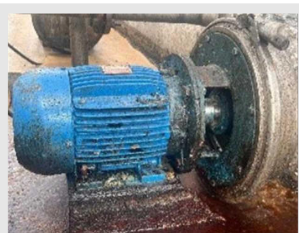
MBTP01 - BOMBA DE TRANSFERENCIA DE PRODUTO MATERIAL - AÇO INOX POTENCIA - 5 CV | Item: 78 |
