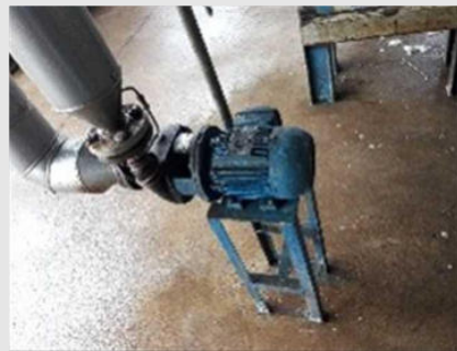
BTPLD01 ? BOMBA TANQUE DE LEVES DESTILADO MARCA WEG CAPACIDADE: RPM 3425 / CV 1,0 | Item: 26 |
