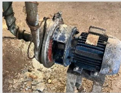
MBM01/MBM02 - BOMBAS TANQUE DE MEDIDA POTENCIA - 5 CV | Item: 38 |
