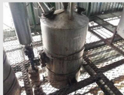
TPLD01 ? TANQUE PULMÃO DE LEVE DESTILADO MATERIAL INOX CAPACIDADE: 0,33M³H MARCA USDA | Item: 17 |
