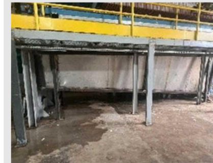
CS01 - CAIXA DE SATURADO MATERIAL - AÇO INOX CAPACIDADE - 10M³ | Item: 42 |
