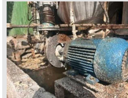
MBF01/MBF02/MBF03 - BOMBA DE FILTRAÇÃO POTENCIA - 5 CV | Item: 36 |
