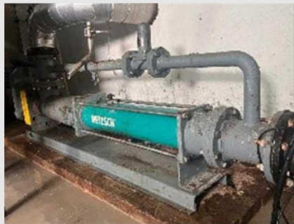
BAC01 - BOMBA DE ALIMENTAÇÃO DO CRISTALIZADO TIPO - NEMO MODELO - NM090BY01L07V | Item: 40 |
