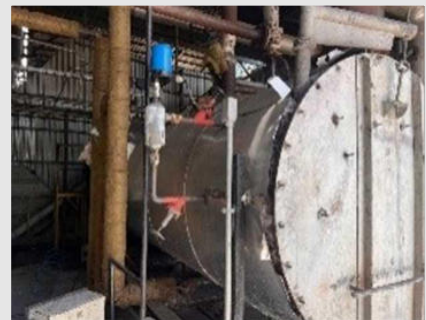
AQF02 - AQUECEDOR DE FLUIDO TÉRMICO FASE VAPOR TIPO - FASE VAPOR POTENCIA - 1.200.000 KCAL/H | Item: 58 |
