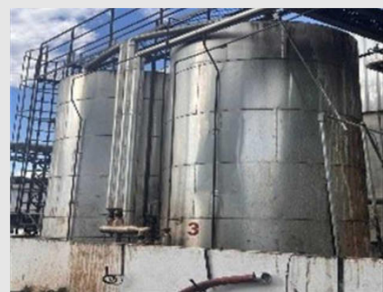
TQS01/TQS02 - TANQUES DE SATURADO MATERIAL - AÇO INOX CAPACIDADE - 12M³ | Item: 52 |
