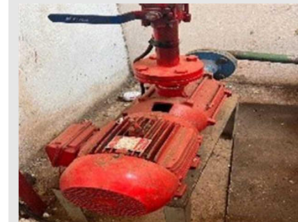
MBSH01 - BOMBA SISTEMA HIDRANTE TIPO - CENTRIFUGA MULTI ESTAGIOS JOCKEY POTENCIA - 7,5 CV | Item: 12 |
