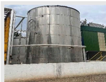
TQED01 - TANQUE ESTOCAGEM DE DESTILADO MATERIAL - AÇO INOX CAPACIDADE - 90 M³ | Item: 73 |
