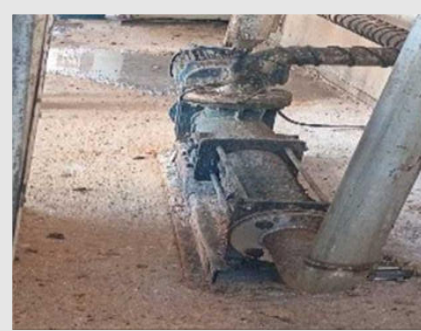
MBAT01 - BOMBA ALIMENTAÇÃO TRIDECANTER TIPO - NEMO MODELO - NM053BY01L07V | Item: 8 |
