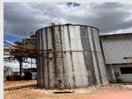
TQAH01 - TANQUE ESTOCAGEM AGUA HIDRANTE MATERIAL - AÇO CARBONO CAP. 60 M³ | Item: 4 |
