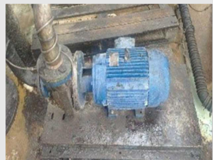
MBTP03- BOMBA DE TRANSFERENCIA DE PRODUTO MATERIAL - AÇO INOX POTENCIA - 15 CV | Item: 81 |
