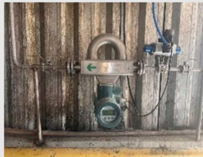
MVC01 - MEDIDOR DE VAZÃO MODELO - RCCT34 ROTAMASS | Item: 35 |
