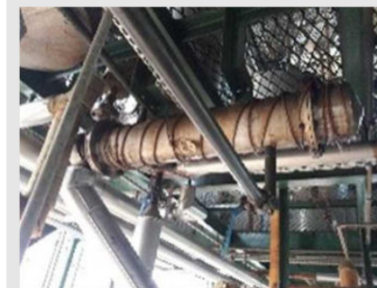
TCVA01 ? TROCADOR DE CALOR MATERIAL INOX CAPACIDADE: 0,5 M³/H MARCA USDA | Item: 18 |
