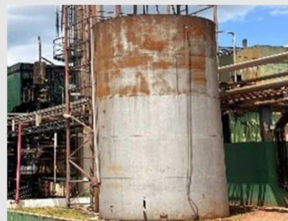
TQAC01 - TANQUE ESTOCAGEM AGUA CALDEIRA MATERIAL - AÇO CARBONO CAP. 40 M³ | Item: 5 |
