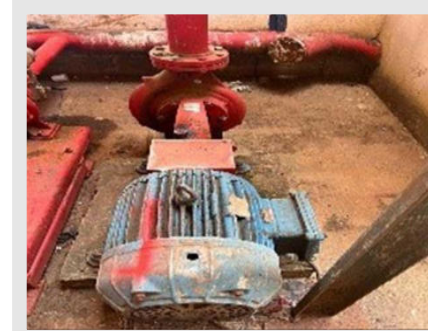
MBSH01 - BOMBA SISTEMA HIDRANTE TIPO - CENTRIFUGA POTENCIA - 15 CV | Item: 9 |
