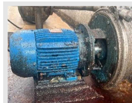
MBTP03- BOMBA DE TRANSFERENCIA DE PRODUTO MATERIAL - AÇO INOX POTENCIA - 7,5 CV | Item: 80 |
