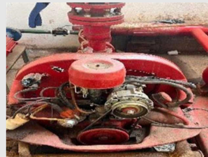
MBSH01 - BOMBA SISTEMA HIDRANTE TIPO - COMBUSTÃO POTENCIA - 1300C | Item: 11 |
