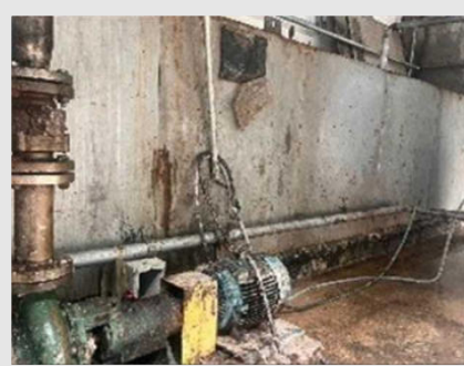
CAG01 - CAIXA DE AGUA GELADA MATERIAL - AÇO INOX CAPACIDADE - 10M³ | Item: 50 |
