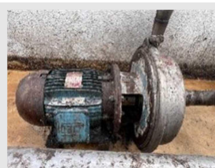
MBTP02 - BOMBA DE TRANSFERENCIA DE PRODUTO MATERIAL - AÇO INOX POTENCIA - 5 CV | Item: 79 |
